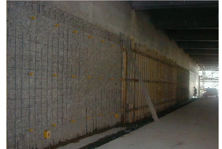
Verstärkung / Instandsetzung einer Tunnelwand
