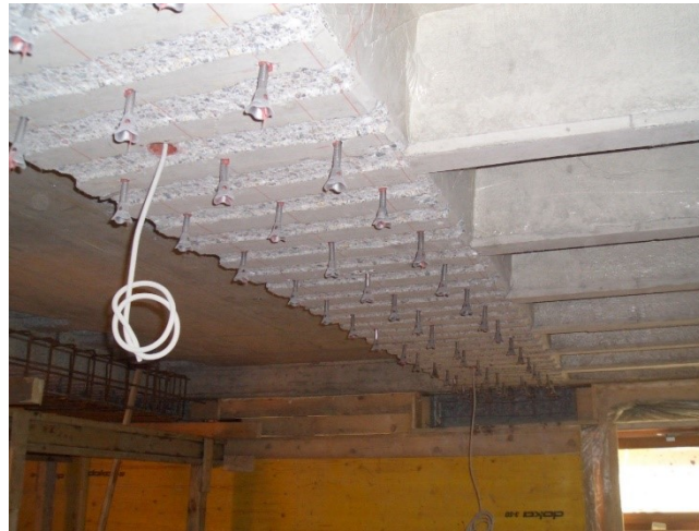
Verstärkung / Instandsetzung Stahlbetonbalken
