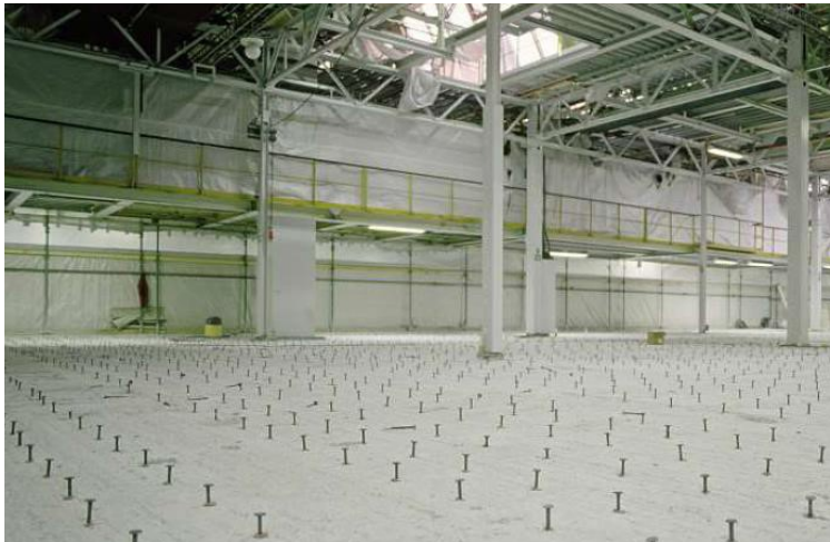
Verstärkung / Instandsetzung der Bodenplatte
