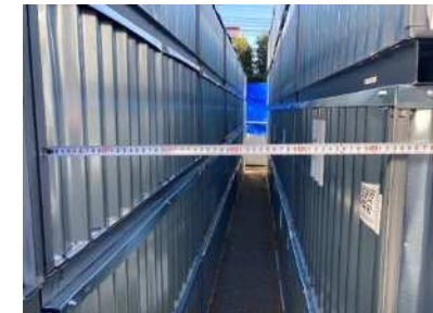
容器同士の間隔-左右約50cm (場所によって変動)
