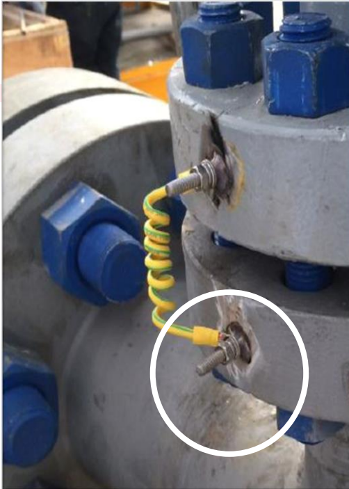
Saldatura ad arco (Gas/Arc) o esotermica
