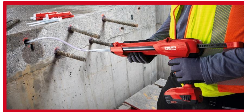
Injektion des chemischen Mörtels
