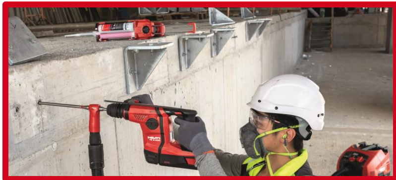
Bohrlocherstellung und Reinigung
