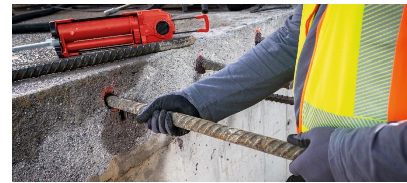
Installation des nachtrgl. Bewehrungsstabes
