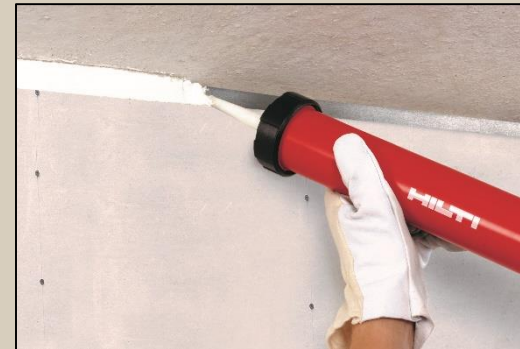
Haut et bas du mur
