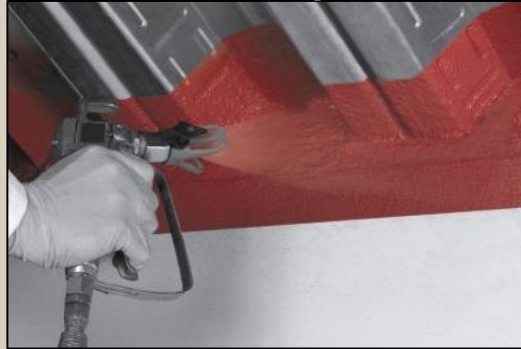
Joint de tablier métallique
